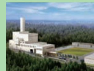
北秋田市クリーンリサイクルセンター エネルギー回収推進施設
